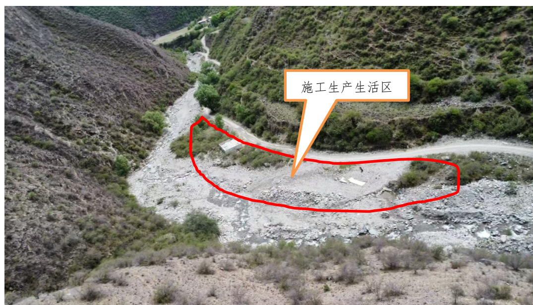
施工生产生活区照片（拍摄于 2026 年 5 月 21 日）
