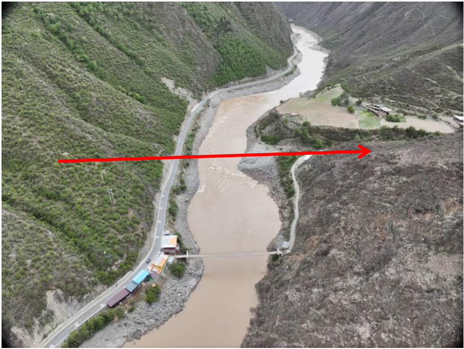
桥梁线路走向（拍摄于 2026 年 5 月 21 日）
